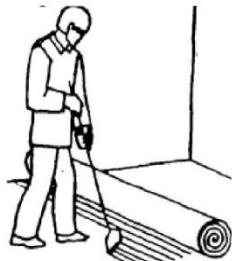
Рис. 4.4 - Разравнивание клея гребенкой
