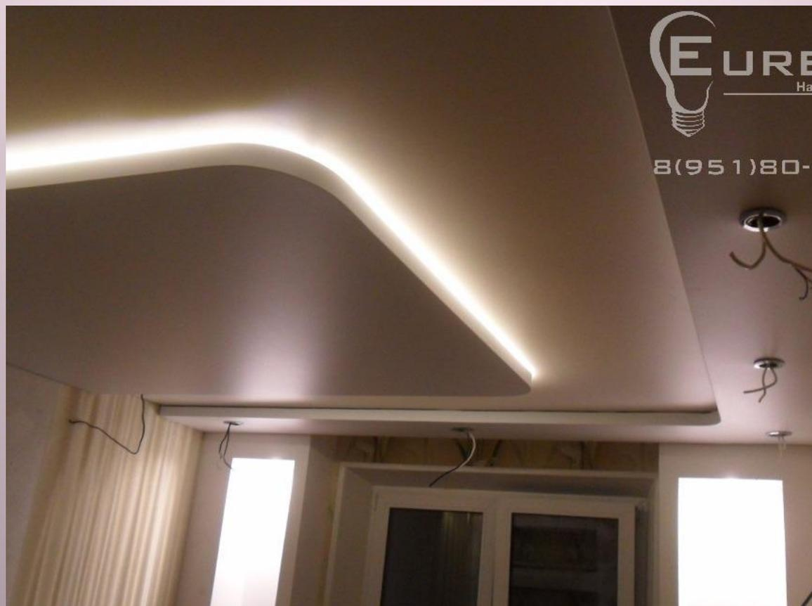
На стыке 2-х уровней нужно слегка округлить выступ багета, чтобы не повредить полотно на остром углу.
