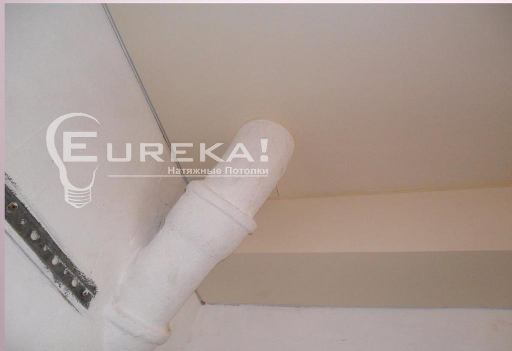
Когда огибаемые трубы находятся в углу, тогда удобнее наклеить пластину и разрезать ее до установки.
