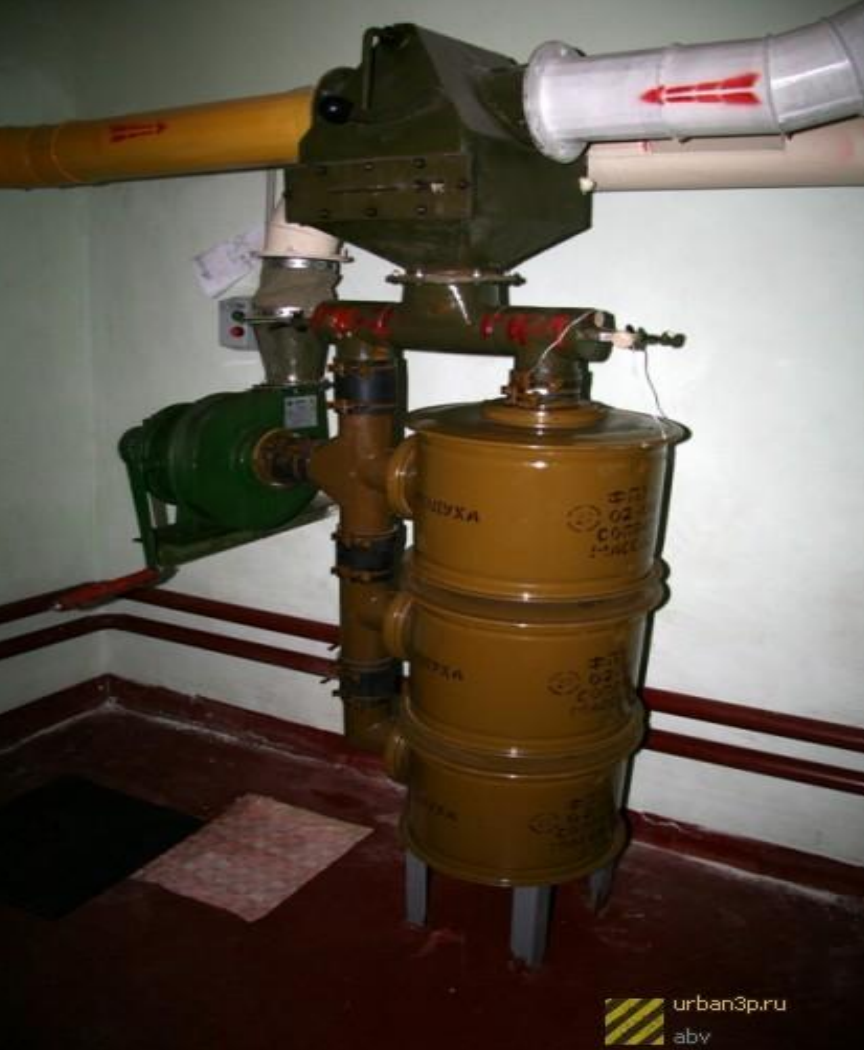
Фильтровентиляционный агрегат.
