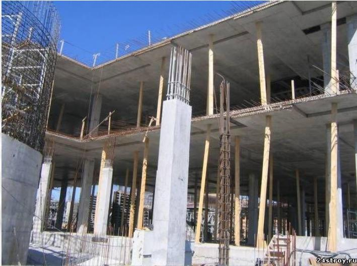
**Несущий остов здания** - пространственная структура горизонтальных и вертикальных несущих элементов (фундаменты, стены, столбы, перекрытия и т.п.), где каждый элемент выполняет специфические функции единой системы.
