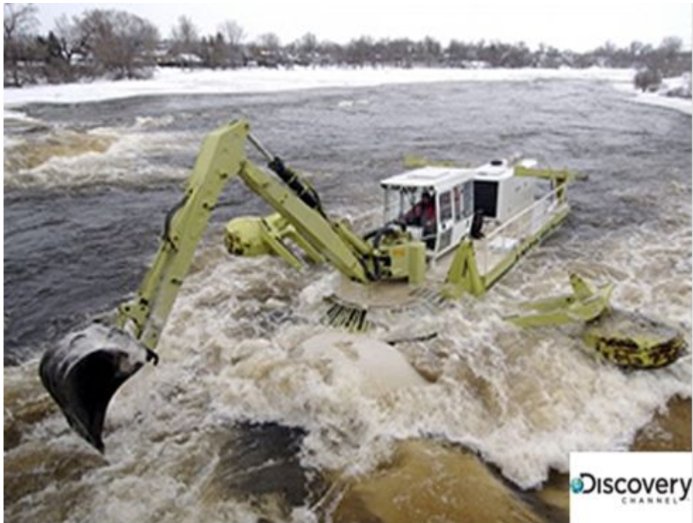
Экскаватор АМФИБИЯ на расчистке ледяных дамб для предотвращения наводнений.
