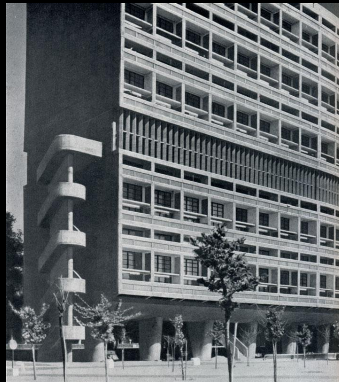
Ле Корбюзье. Жилой дом в Марселе Фрагмент фасада. 1947–1952
