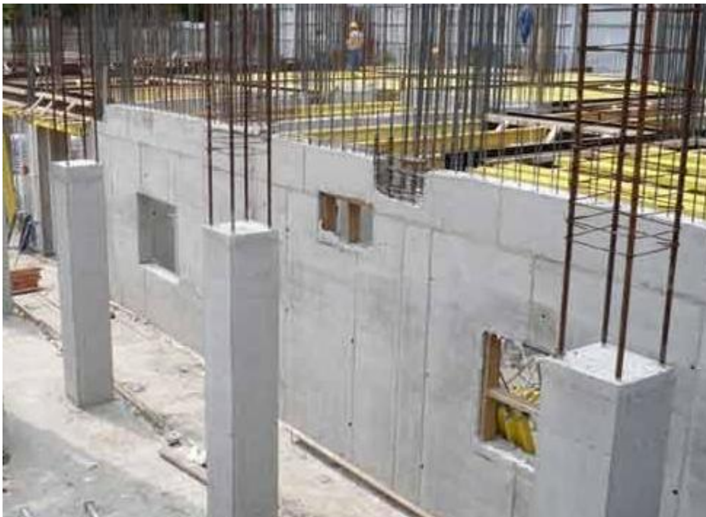
Монолитные железобетонные конструкции
