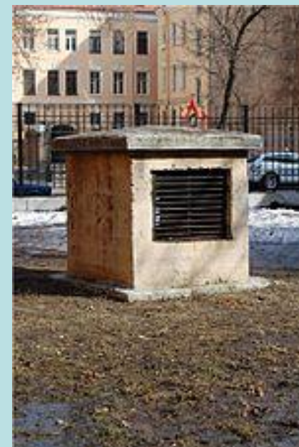
Оголовок аварийного выхода
