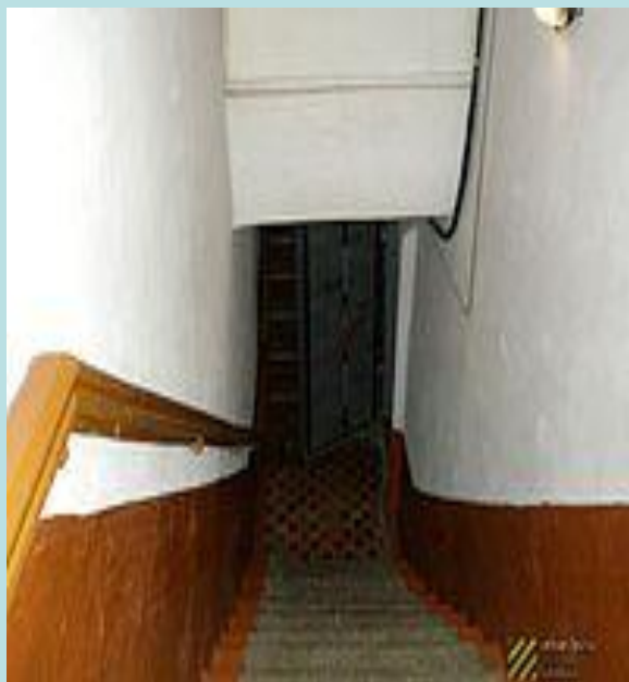
Лестничный спуск входа в убежище.
