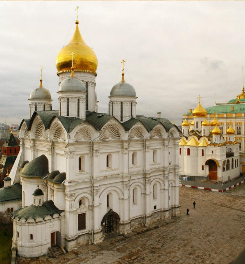
Архангельский собор Московского Кремля. Вид с северо-востока. Арх. Алевиз Новый.
