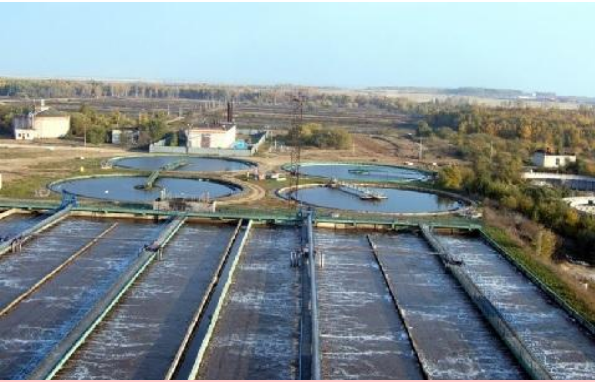
Городские очистные сооружения
