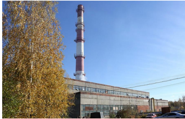
Котельная пос. Оболенск
