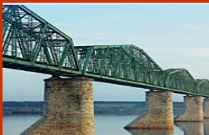
Транссибирская магистраль. Мост через Каму близ Перми. 1910 год. Фотография Сергея Михайловича Прокудина-Горского (1863-1944).
