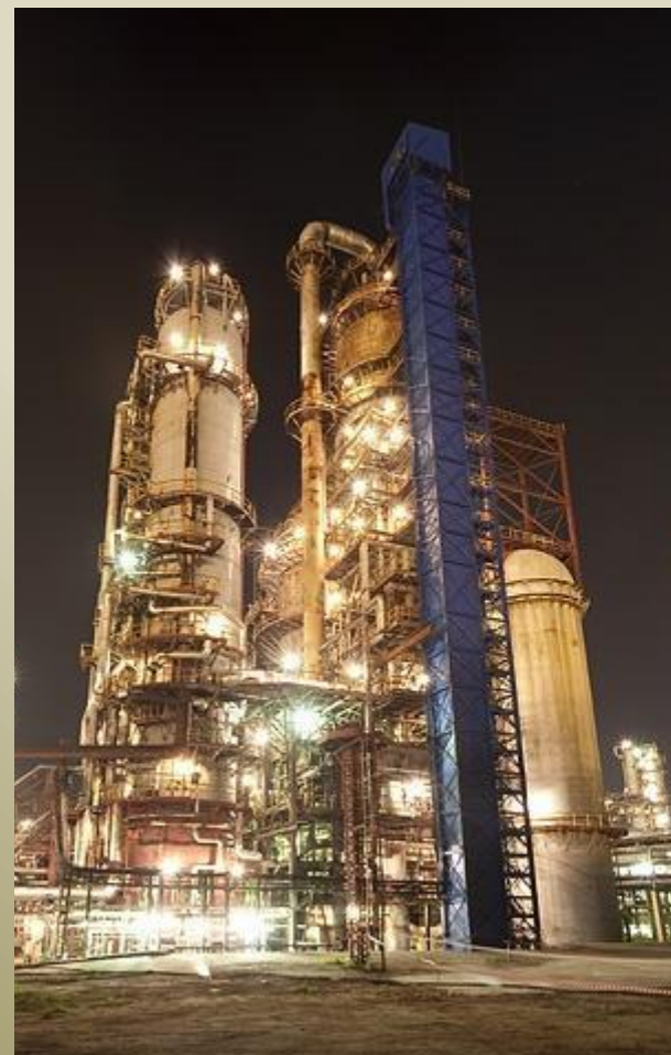
Установка каталитического крекинга Г-43-107
