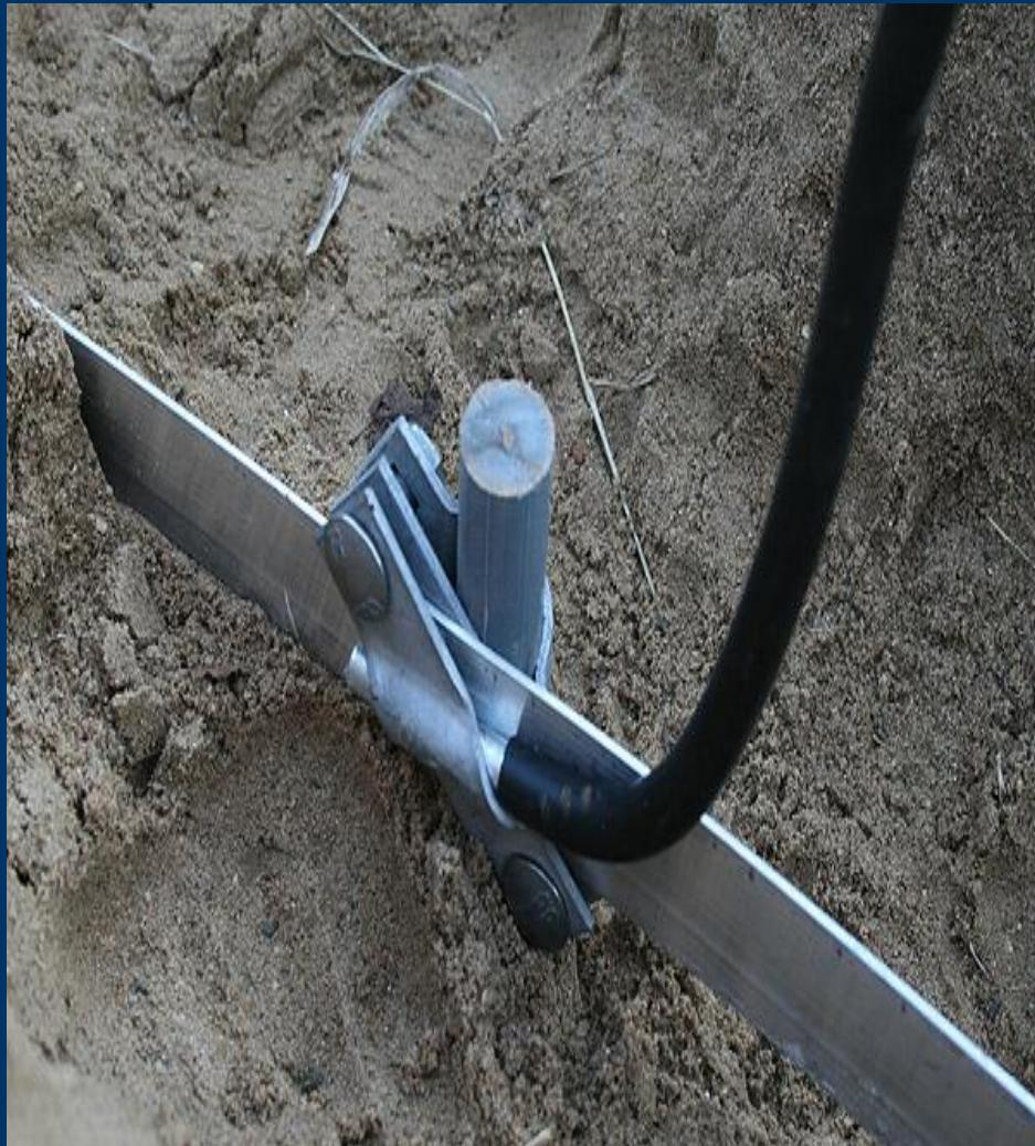
**Заземляющее устройство** – это совокупность заземлителя и заземляющих проводников.
