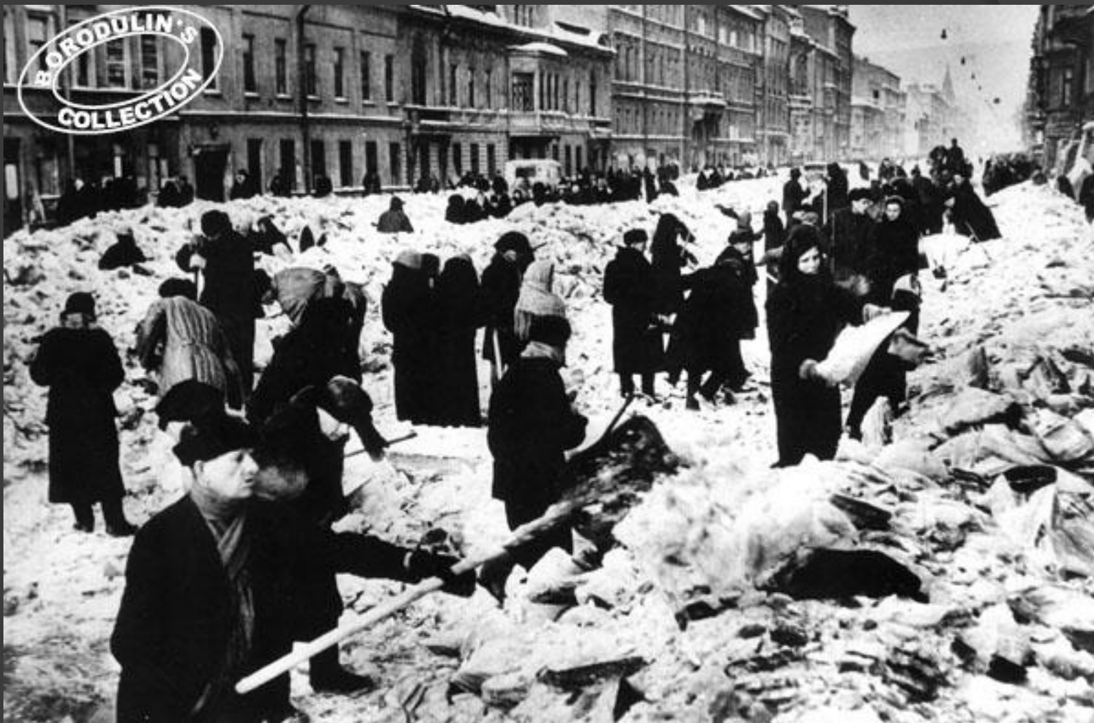
Восстановление Невского проспекта.
