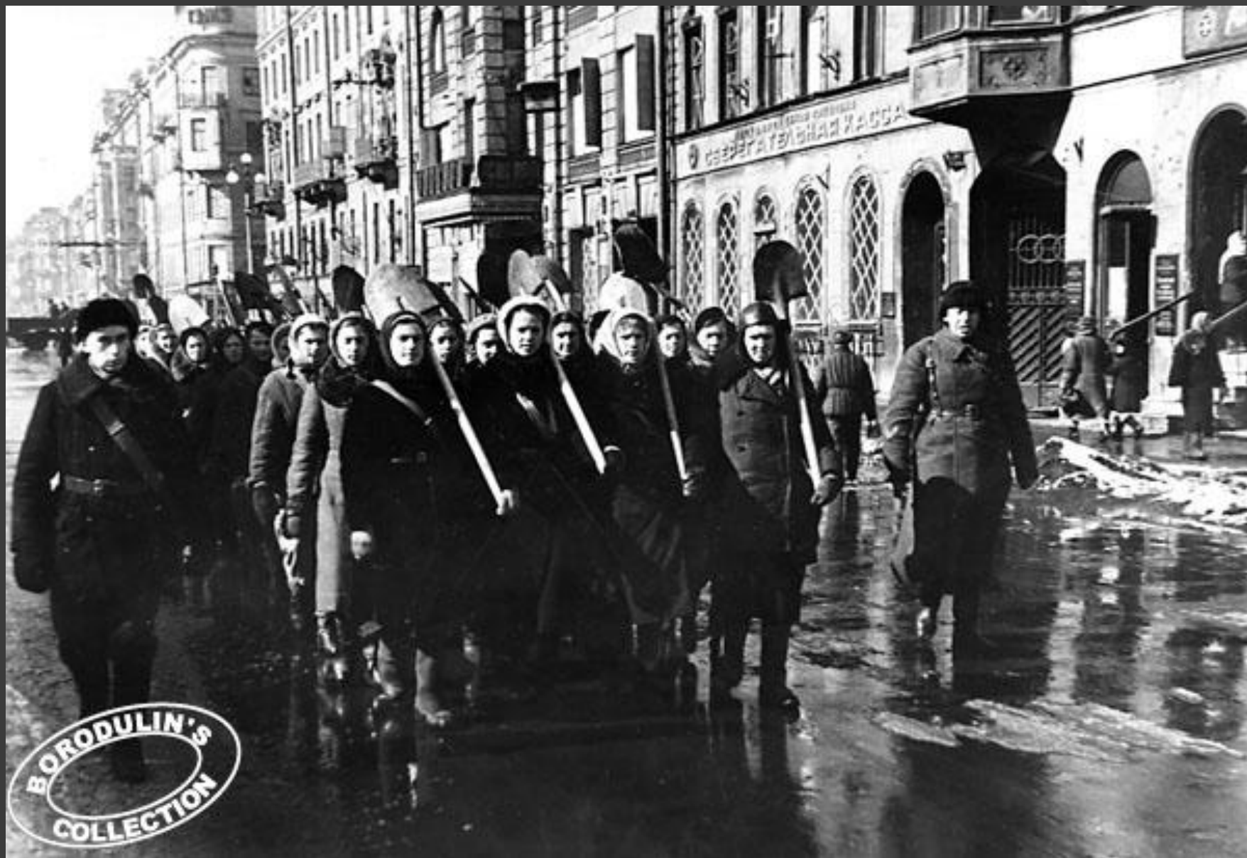
Женский строительный батальон.
