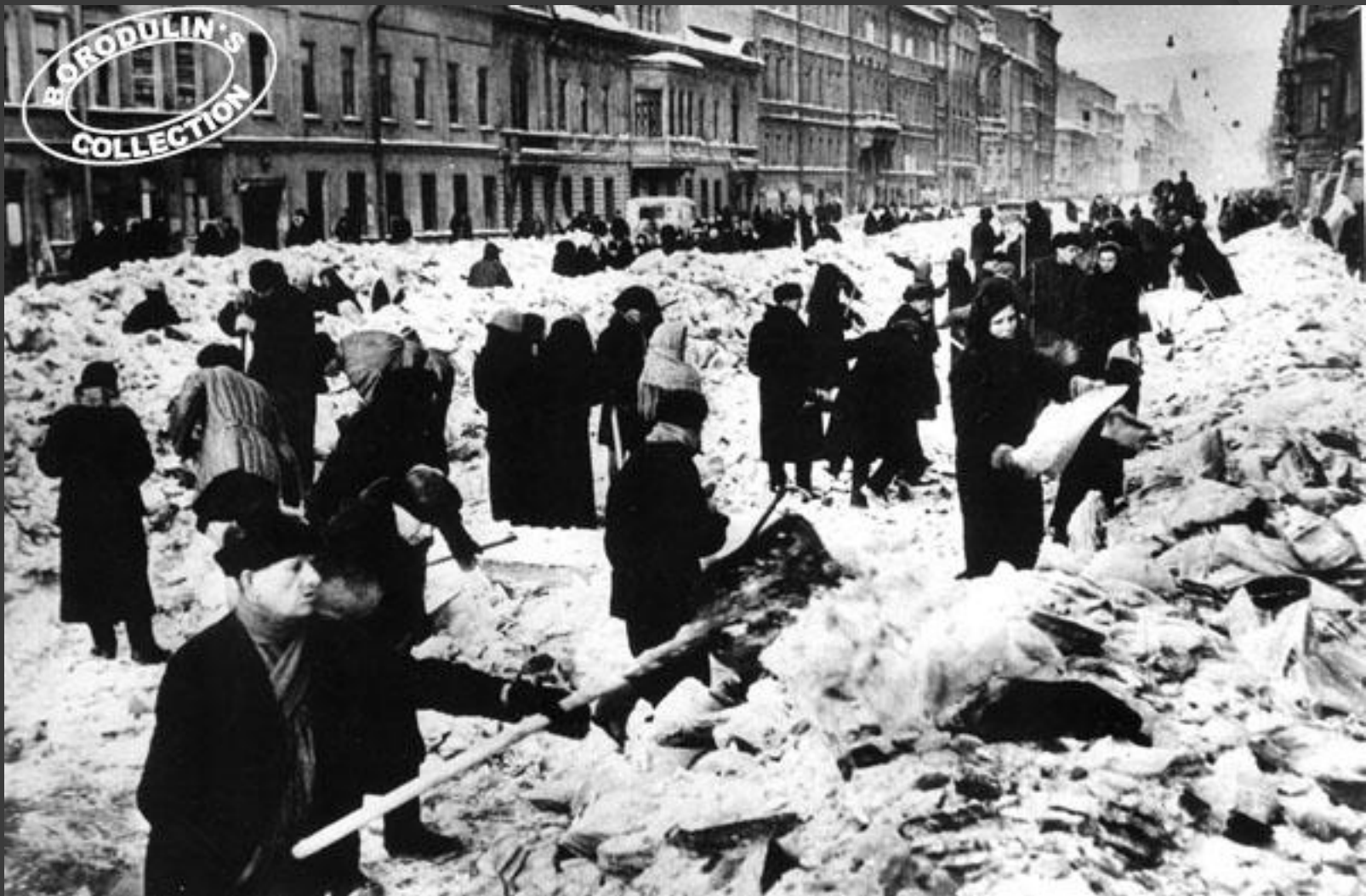
Восстановление Невского проспекта.
