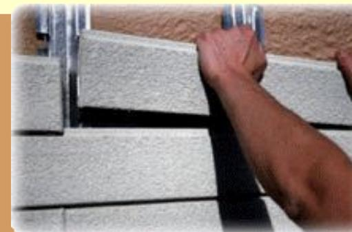
Навешивание панелей облицовки с помощью замка-защелки
