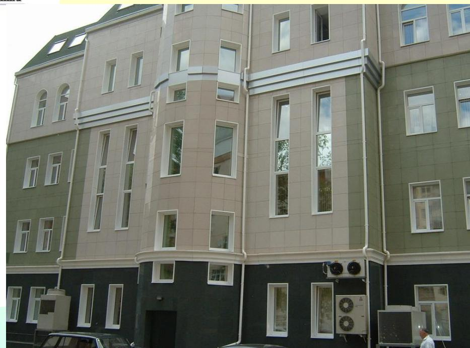
Система наружной теплоизоляции с облицовкой керамическим гранитом
