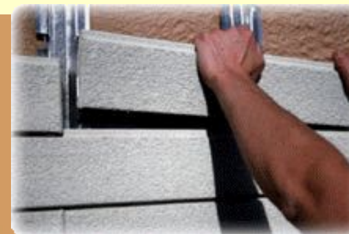
Навешивание панелей облицовки с помощью замка-защелки
