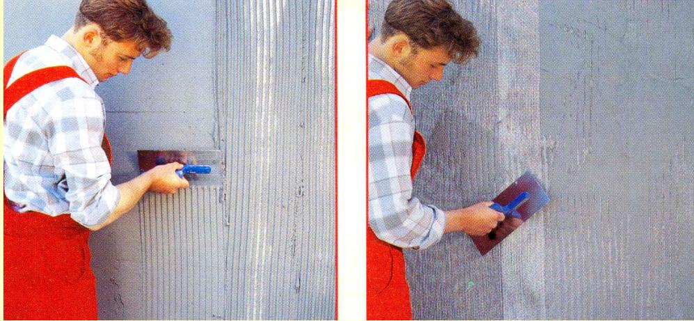
**7.Нанесение раствора. Армирование поверхностей стеклосеткой, утопленной в слое клеевого состава.**
