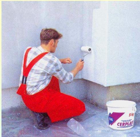
**8.Нанесение второго слоя, либо слоя водоотталкивающей штукатурки**
