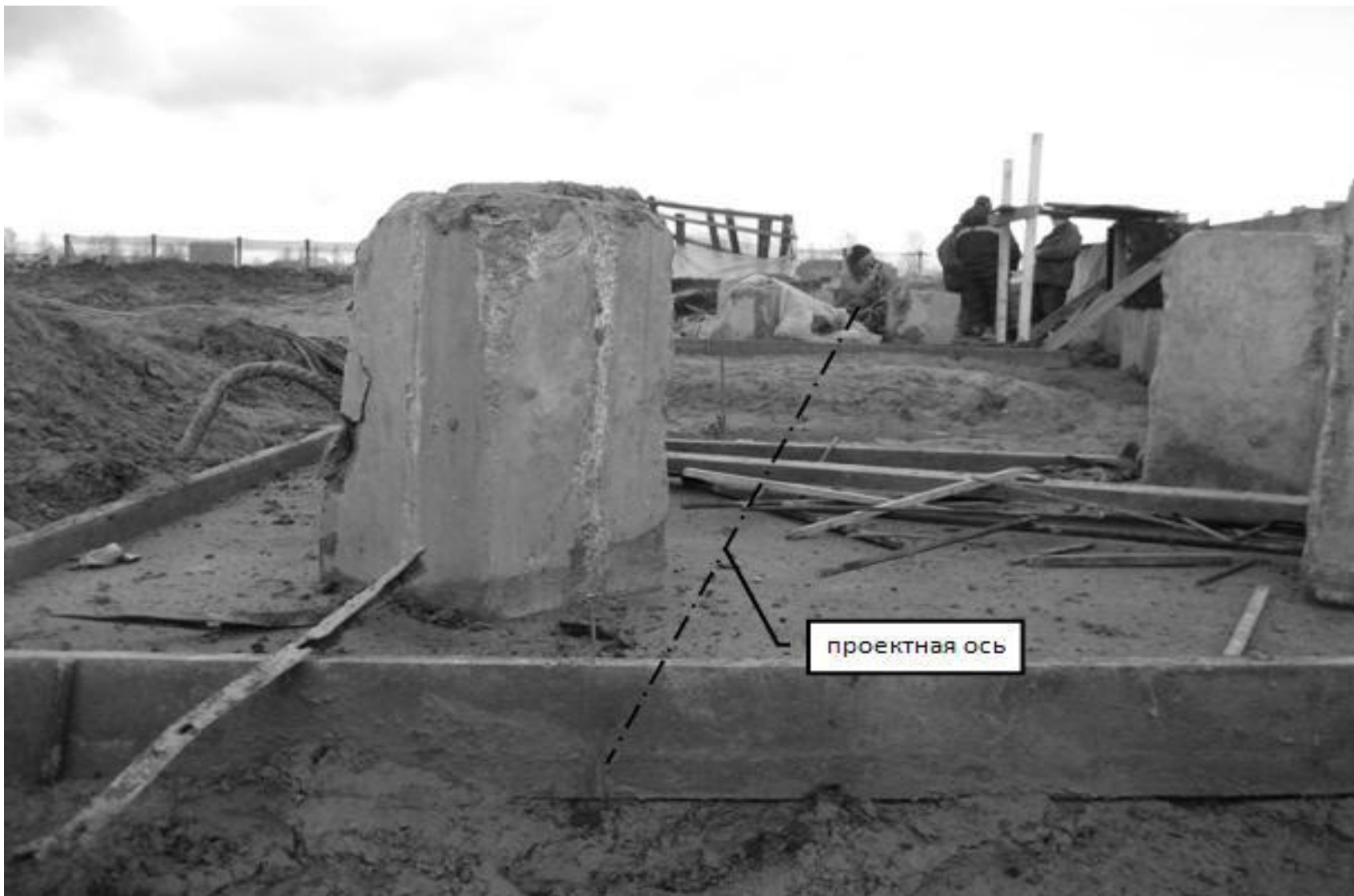
Фотография смещенного свайного куста относительно проектной оси
