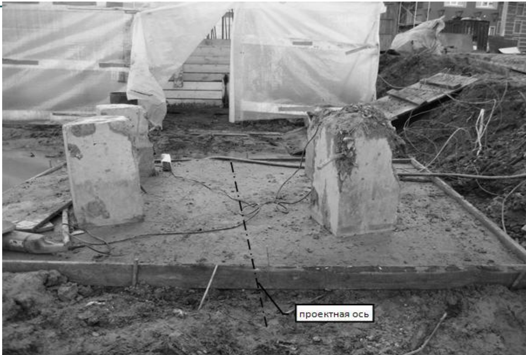
Фотография свайного куста под ростверк . Смещение относительно цифровой оси, в сторону ж/б заглубленного сооружения.
