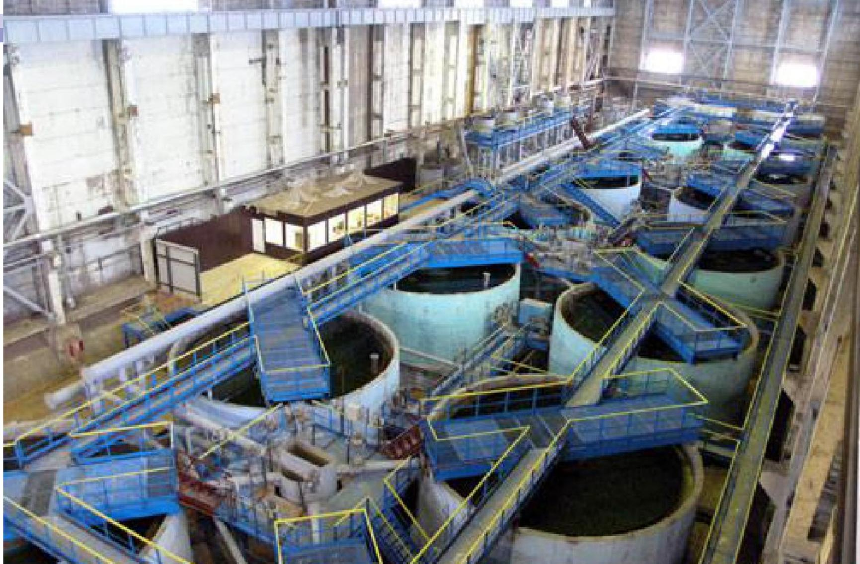
Станция нейтрализации шахтных сточных вод УГОК г. Учалы (блок вертикальных отстойников)
