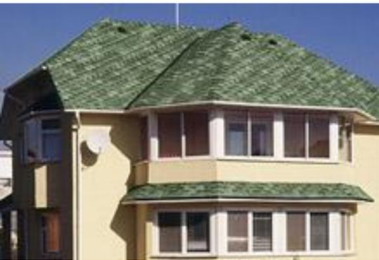
**Гибкая черепица** - условное название небольших (длиной 900-1000 мм, шириной 300-420 мм и толщиной 3-4 мм) многослойных битумных пластин с фигурными вырезами по одному краю. Ее еще называют кровельной плиткой, **гонтом**. Обычно одна пластина имитирует 3-4 черепицы, форма которой может быть шестигранной, прямоугольной, волнообразной и т.п.
