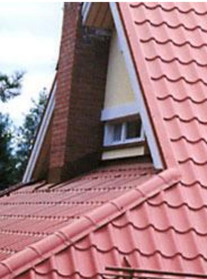
**Металлочерепица** — это кровельные листы из оцинкованной стали толщиной 0,4 – 0,55 мм, защищенной антикоррозионным слоем с цветным полимерным покрытием.
