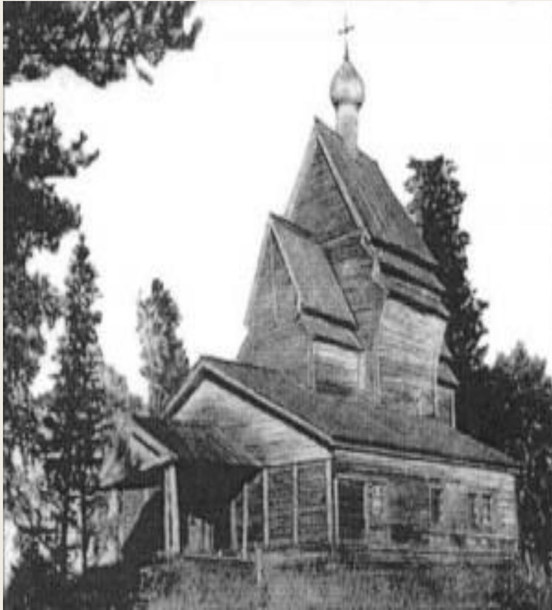
Георгиевская церковь. Село Юкосово. Ленинградская область. 1493 г.
