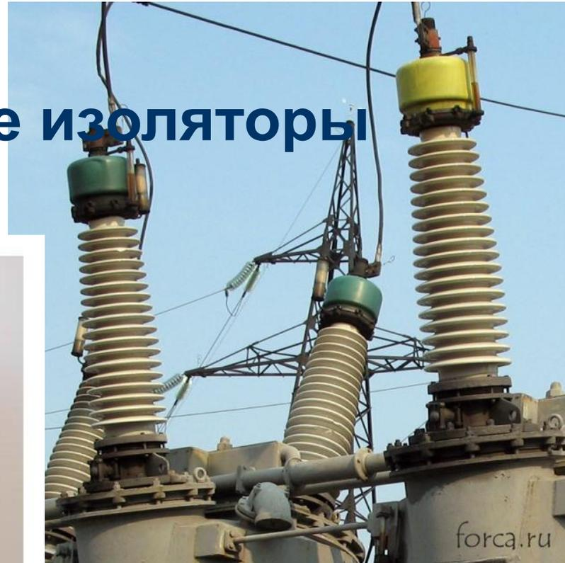
**Опорные изоляторы** служат для крепления токоведущих частей и изоляции их друг от друга и от заземленных частей.
