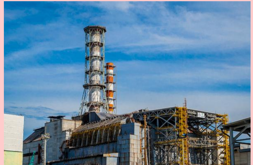
Строительство защитного купола
