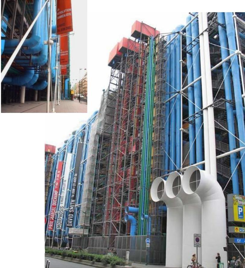
Один из фасадов образован сетью труб различного диаметра, имеющих чисто функциональное назначение (водоснабжение, вентиляция, электропроводка и др.). Структура этого здания действительно ближе дизайну, чем архитектуре.
