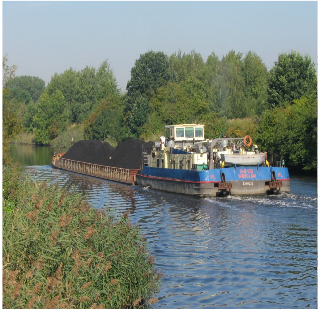
Barka na Kanale Gliwickim
