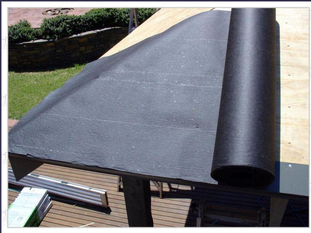
Толь - наиболее простой гидроизоляционный рулонный материал, представляющий собой кровельный картон, пропитанный дегтем и имеющий защитный крупнозернистый или мелкозернистый слой. Толь клеят на горячую дегтевую мастику или крепят на толевые гвозди (если основа - дерево). Наиболее распространены сегодня рулонно-битумные материалы.
