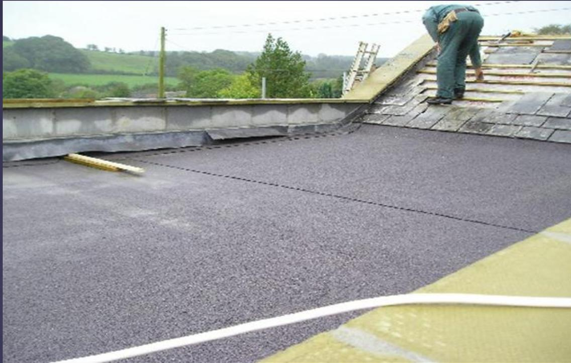
Пергамин. Основа - кровельный картон; вяжущее - битум; защитный слой отсутствует: более тонкий и менее прочный двусторонний оклеечный материал, применяемый для внутренней подкладки под другие гидроизоляционные материалы;
