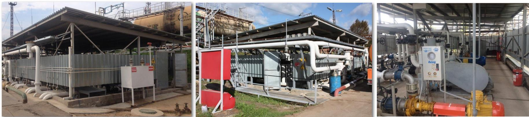
Насосная станция выполнена в виде навеса из металлических элементов (стоек, связей, балок, прогонов). Ограждение и покрытие насосной выполнено из стальных профилированных листов. Основание выполнено в виде монолитной ж/б плиты. Отбортированная площадка полов имеет уклон в сторону технологического приемка для сбора проливов.
