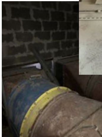
Отсутствие герметичности на вентиляционном коробе
