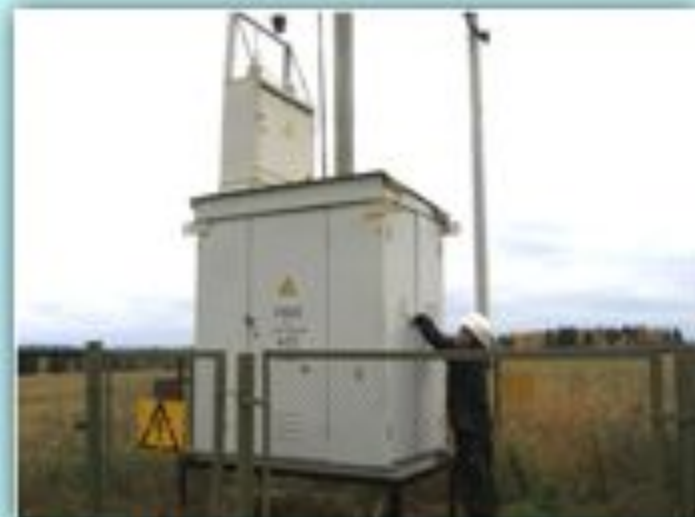
Рис. 22. Монтаж станции катодной защиты
