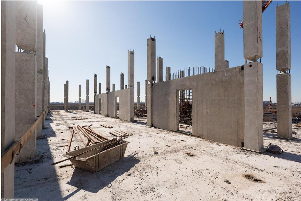
Данные элементы связывают между собой и друг с другом колонные панели, при этом они обеспечивают пространственную жесткость всей постройке. Они должны находиться в зданиях во всех направлениях таким образом, чтобы происходило пересечение и образовывались Т-образные или Г-образные фигуры.
