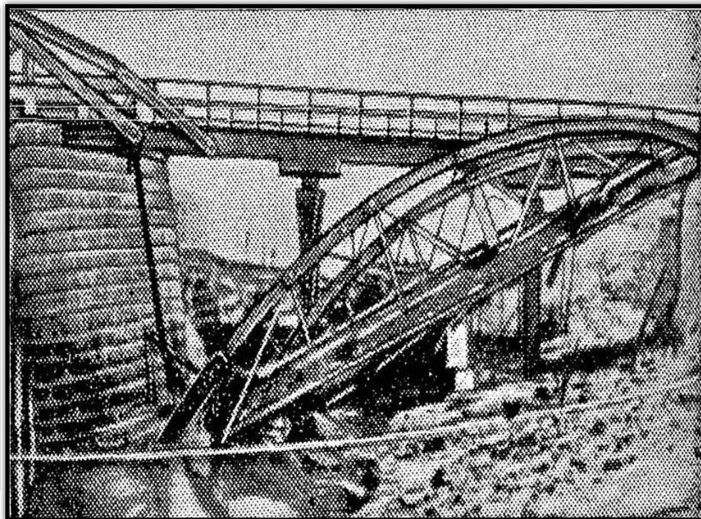
Осадка и наклон отдельно стоящей мостовой опоры
