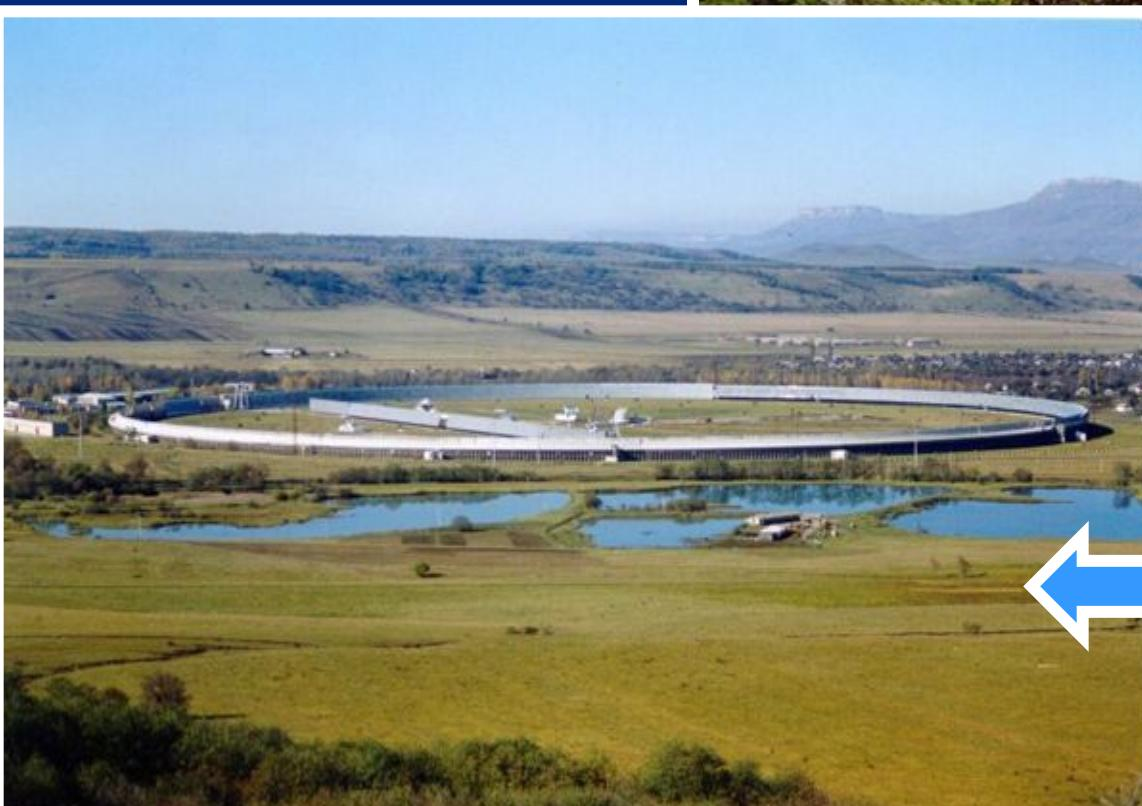
В 1976 году на Северном Кавказе в России начал работать 600-метровый радиотелескоп РАТАН-600. Угловое разрешение радиотелескопа на волне 3 см составляет 10".
