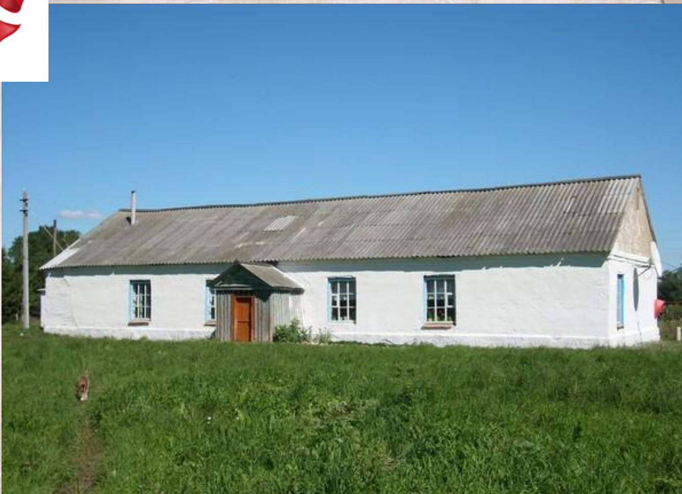
Здание Тазнеевской начальной школы (год постройки - 1968)
