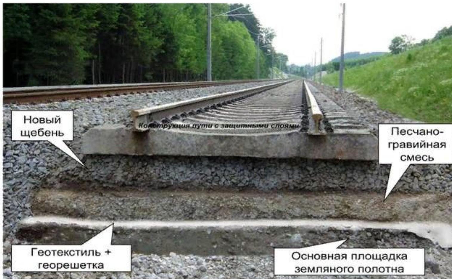
Рис. 3. Современная конструкция верхнего строения пути
