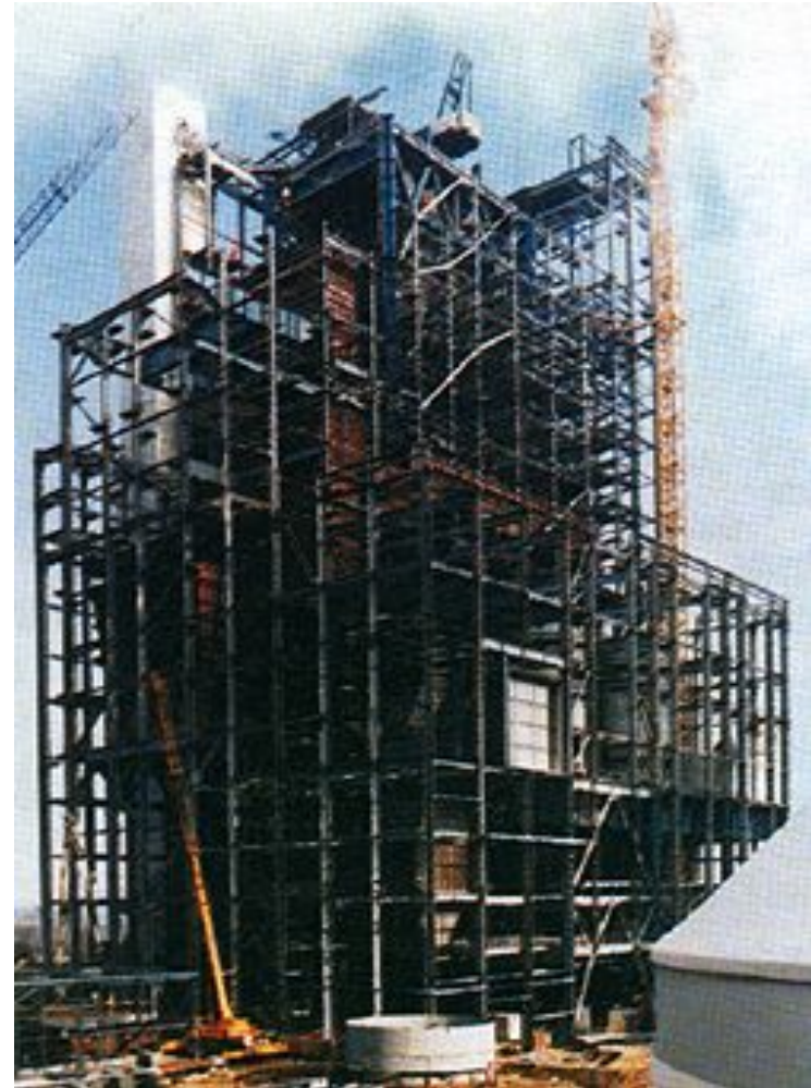
Возведение котлоагрегата
