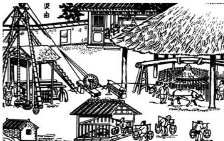
Расцвет китайского способа бурения на глубины свыше **500 м** приходится на **VI - III в. до н.э.** В Китае, в провинции Сычуань в **221 г. до н.э.**, из скважины на соленую воду получили нефть и газ”. Порой эти скважины вообще давали только метан, за что были названы “огненными колодцами.
