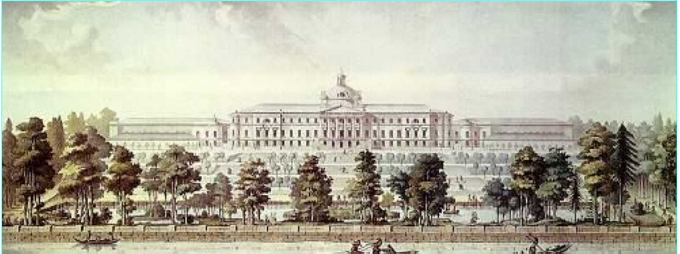
Здание Градской больницы арх. М.Ф.Казиков.
