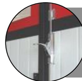
Распашные ворота могут быть изготовлены до 3 м по ширине и до 2,4 м по высоте
