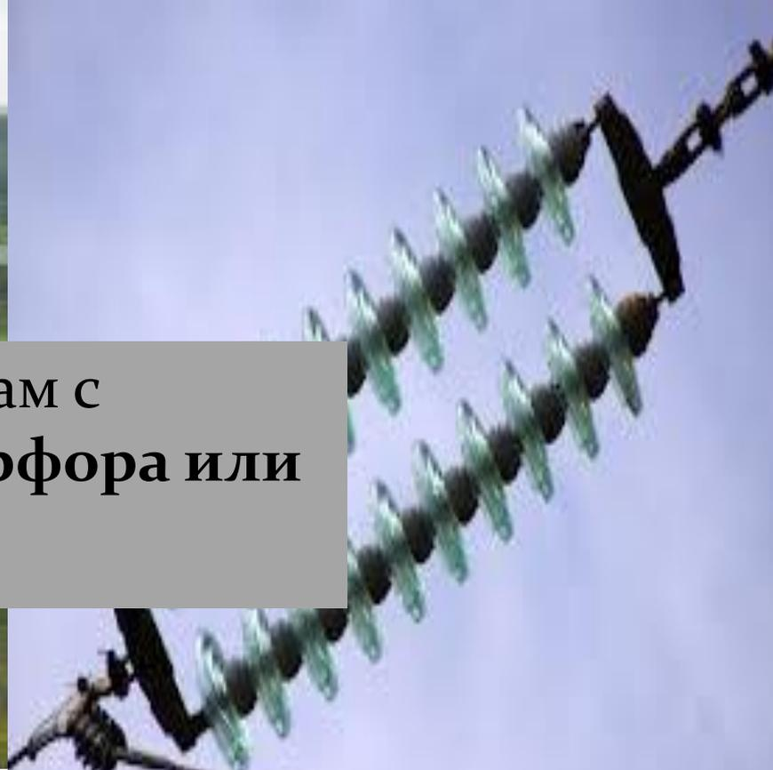
Провода ВЛЭП крепят к опорам с помощью изоляторов из фарфора или закаленного стекла.
