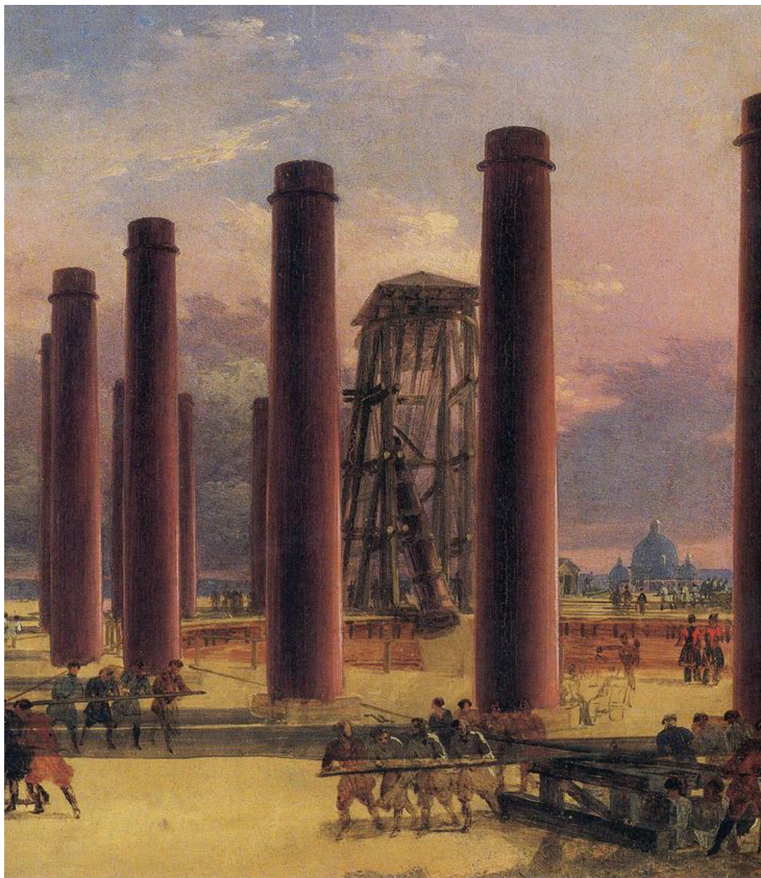
Установка колонн главного купола Исаакиевского собора
