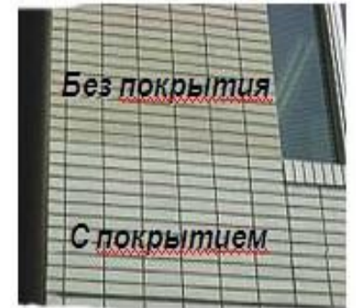
Наружная очистка воздуха
