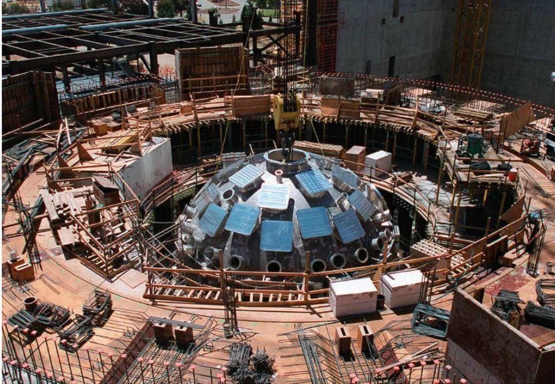
В Национальной лаборатории Лоуренса Ливермора в Калифорнии находится камера с 192 лазерами, которые пытаются сжать частицы водорода до реакции синтеза. 500 триллионов ватт энергии используются для того, чтобы когда-нибудь возместить эту самую затраченную энергию с лихвой, получив большее ее количество в результате слияния частиц водорода.
