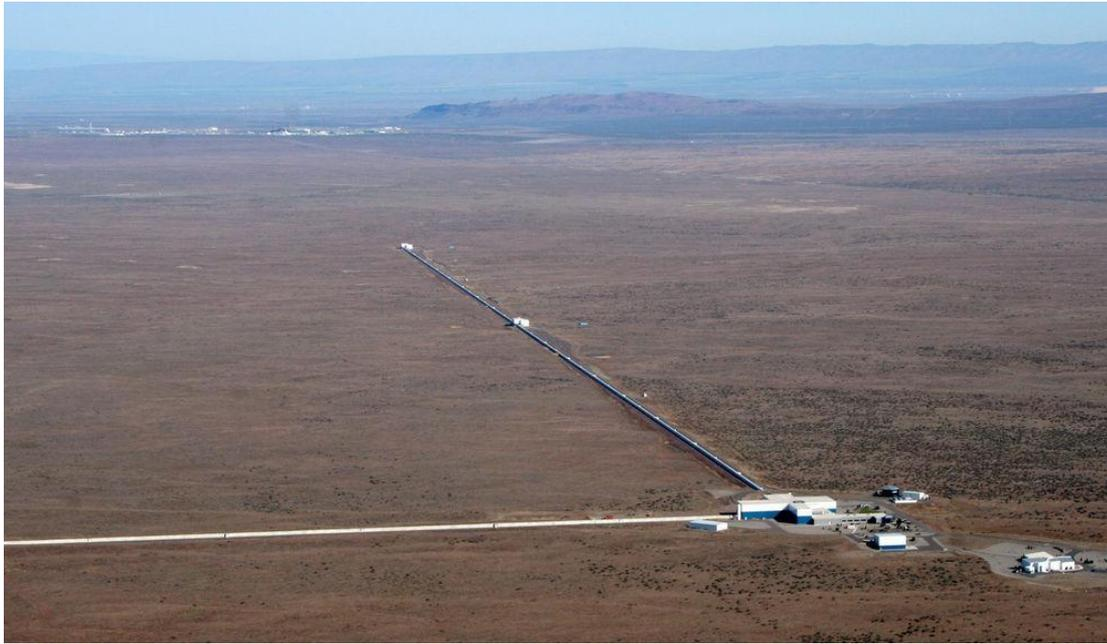
Обсерватории образуют лазерный гравитационно-волновой интерферометр LIGO. В основе системы - две Г-образные вакуумные трубы, внутри которых расположены лазерные интерферометры, реагирующие на гравитационные волны. Специалистам комплекса LIGO удалось не только поймать гравитацию за хвост и подтвердить правоту Эйнштейна, но и услышать звуки столкновения черных дыр.
