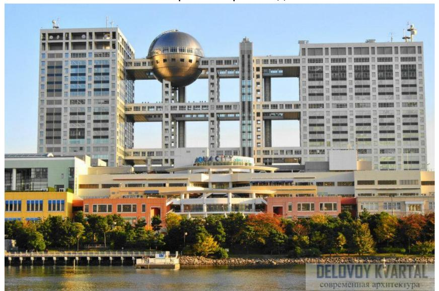
• Строительство 25-этажного здания странного футуристического вида продолжалось в течение трех лет. Самая примечательная часть сооружения металлический шар диаметром 52 метра весом около 1200 т. Шар собрали на земле и подняли на высоту 125 м. Сфера служит смотровой площадкой, откуда открывается живописный вид на Токийский залив.
