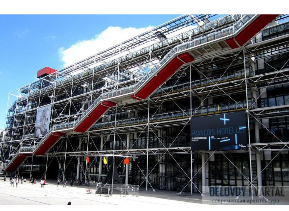
• Центр Жоржа Помпиду в Париже. Построен по новаторскому проекту Ренцо Пияно и Ричарда Роджерса, выбранному из 680 конкурсных работ. Сооружение хоть и имеет строгий прямоугольный объем, но общий силуэт его нечеток. А из-за вынесенных на фасад всех конструктивных, инженерных и транспортных систем создается впечатление, что здание вывернуто наизнанку.
