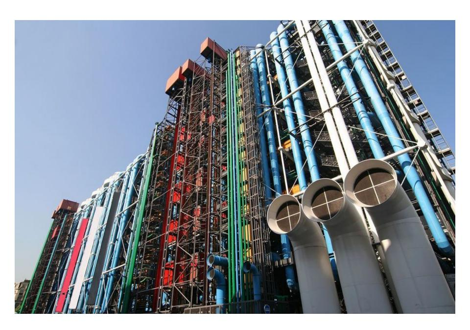
• Здание представляет собой стеклянный параллелепипед очень больших для центра Парижа размеров. Оригинальная идея архитекторов была в расположении всех технических конструкций (арматурные соединения, все трубопроводы, лифты и эскалаторы) снаружи здания, что позволило высвободить максимум полезной площади.
