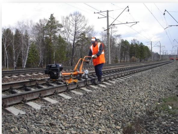
После пополнения балластной призмы, подтягивания гаек болтов (шурупов) до нормативных значений ограничение скорости движения поездов отменяется.
