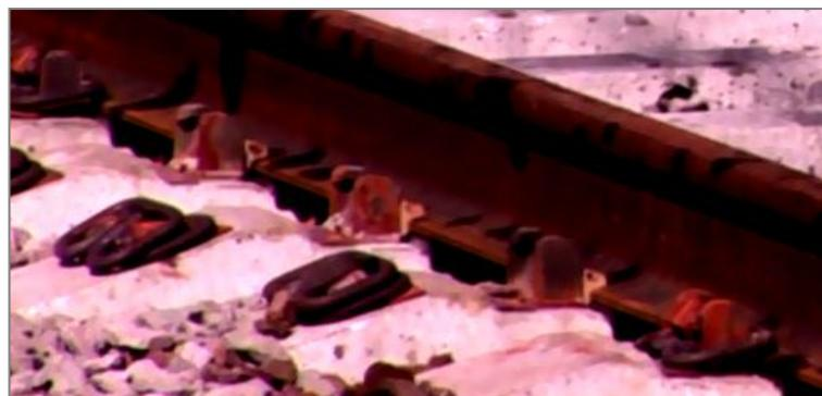
При подготовительных работах до «окна», а также при открытии движения после его завершения допускается частичное снятие клемм (или перевод их в монтажное положение) на инвентарных рельсах (сменяемых или разряжаемых плетях).
