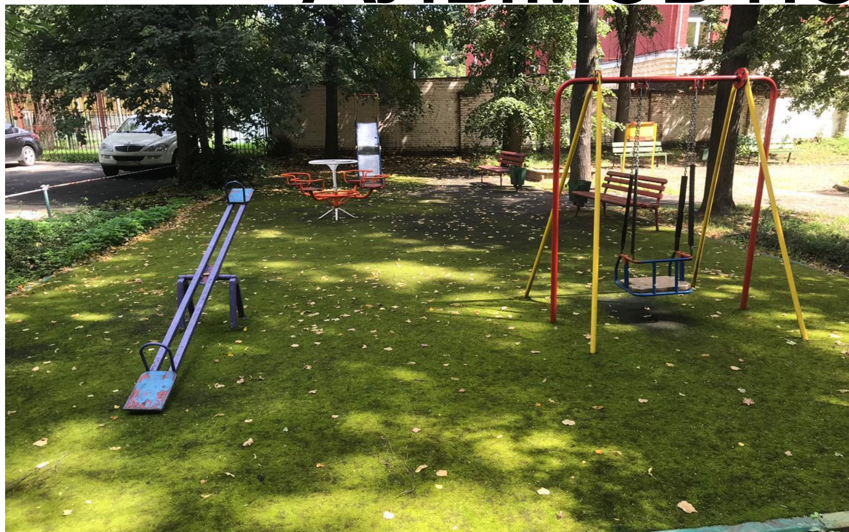
Демонтаж детской площадки без восстановления. В связи с прохождением коммуникаций.
