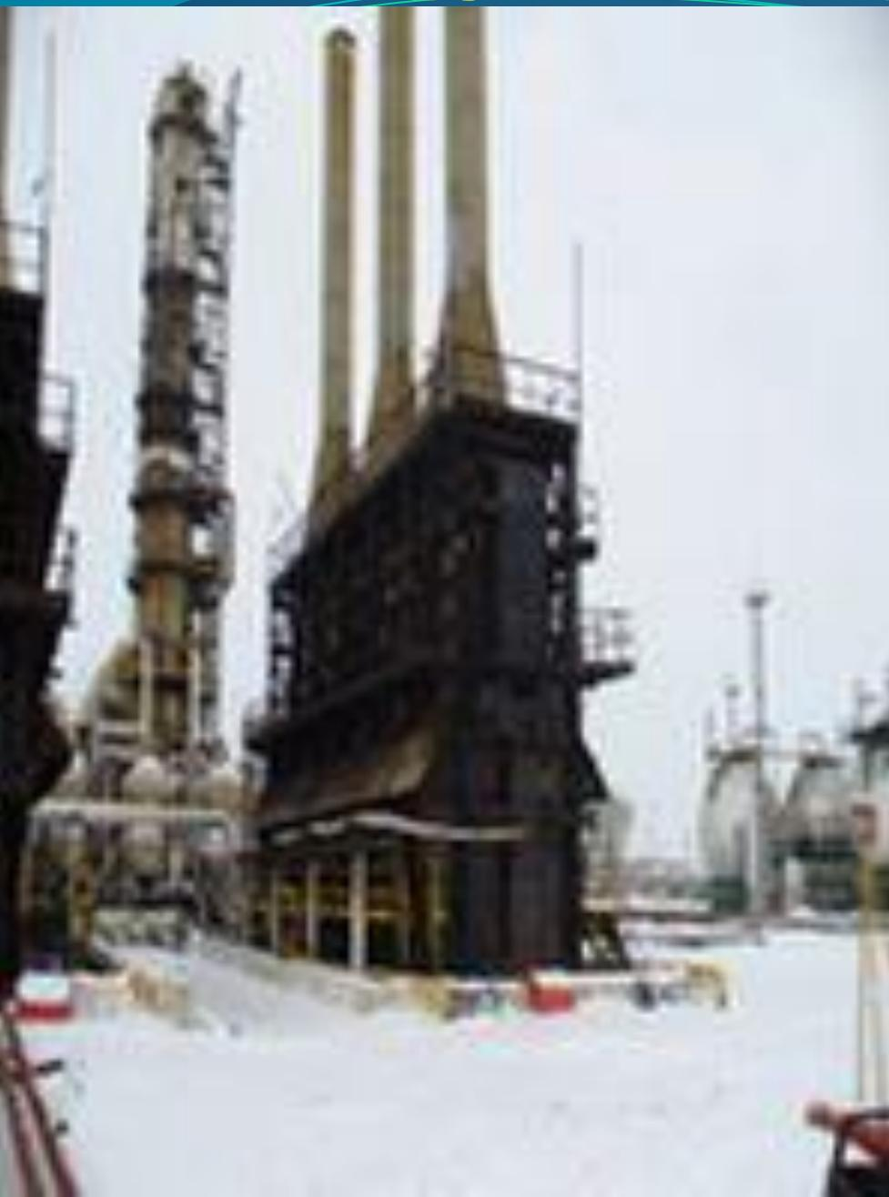
Печь – трубчатая коробчатая с верхним отводом дымовых газов и горизонтальными настенными или центральными трубными экранами
