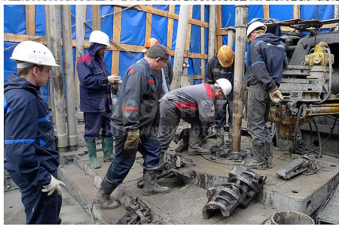
Обсадную колонну в наклонную скважину следует спускать по возможности быстрее. Для этого рекомендуется в период подготовки скважины к креплению собрать часть колонны в колена и установить их за пальцем в буровой вышке.
