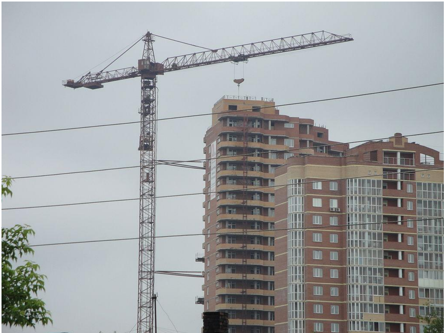
Рис. 16. Приставной кран, прикрепленный к зданию
