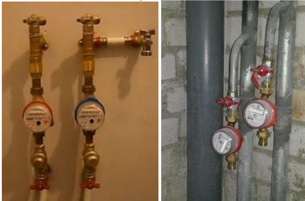
Трубы – полипропиленовые. Начиная со второго этажа стояки канализации проложены в БИК.
