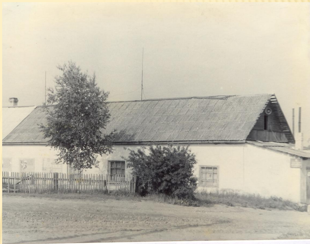
Здание спичечной фабрики, где при князе была конюшня, до войны – пожарное депо, после войны (с 1953 г. по 1999 г) – клуб
