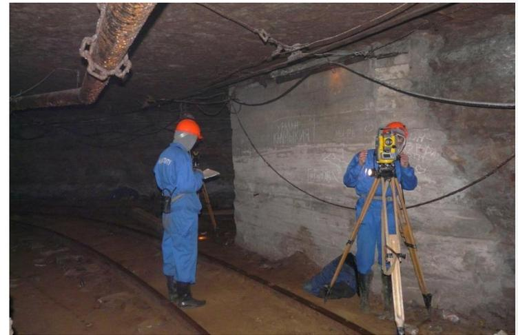
Сущность способа состоит в сравнении координат одной и той же точки, полученных по подземному полигонометрическому ходу и переданных с поверхности через скважину.
